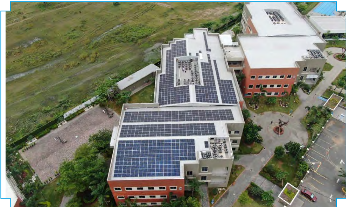
Planta solar fotovoltaica
